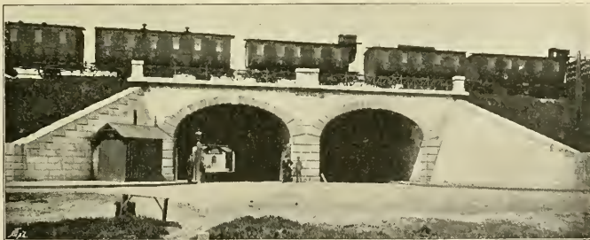
Abb. 134. Gewölbte Durchfahrt aus Stampfbeton auf dem Brünner Nordbahnhofe. [Kaiser Ferdinands-Nordbahn.]
